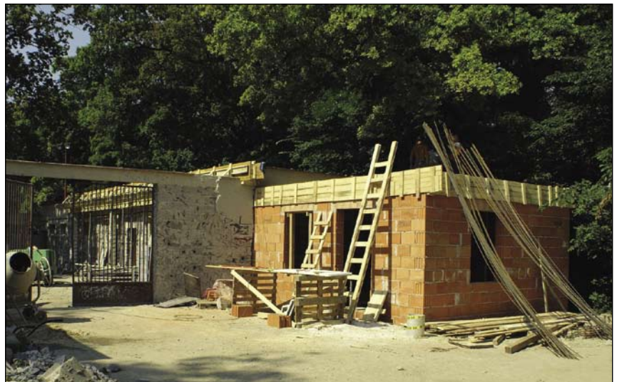
Práce sa začali na amfiteátri v Pomlé
