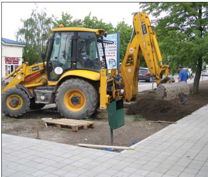
Terénne úpravy na Bratislavskej ceste
