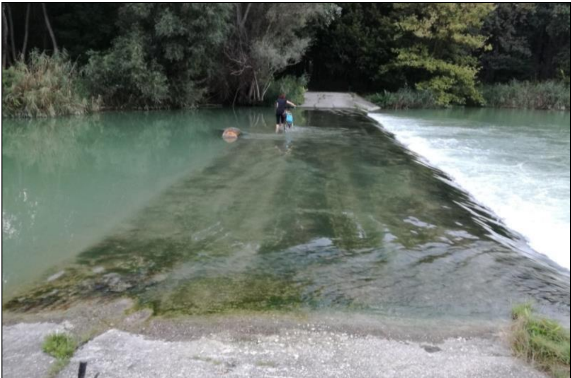
Obrázok č. 2. 10: Spevnená lesná cesta v CHKO Dunajské luhy s potenciálom zariadenia ekologickej infraštruktúry
