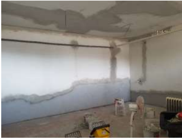
Oprava a maľovanie stien a elektrického vedenia na 1. poschodí
