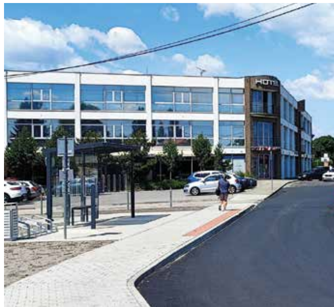
A felújítás teljes költsége 120 ezer euró
